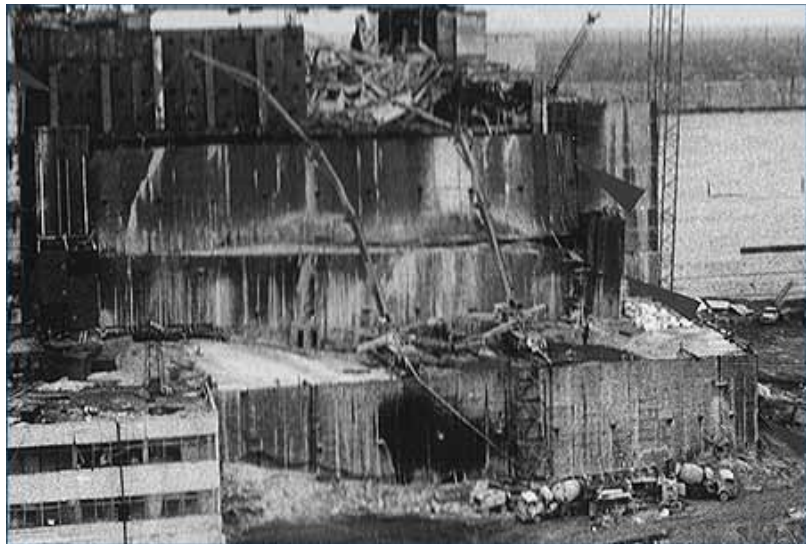
Posa in opera di calcestruzzo nel terzo gradino del muro del sarcofago
